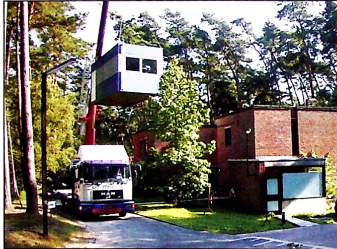
Des cabines métalliques pour une vingtaine de membres du personnel de Lennox.
