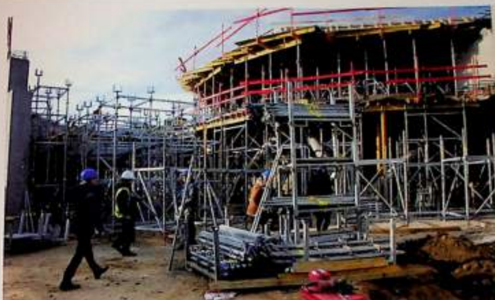
Le rond-point situé sous l'immeuble circulaire est un des grands enjeux du chantier Agora.
